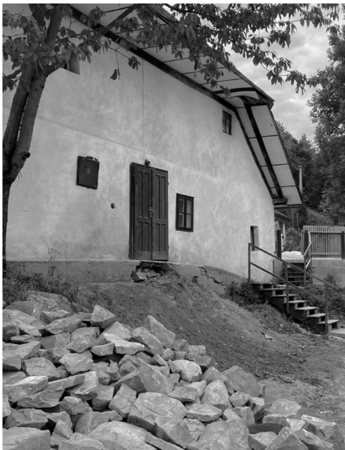
Vo vidieckej záhrade sa na spevnenie svahu použil kameň, ktorý sa v nej už nachádzal. Lokálny materiál dodal prirodzený ráz.
